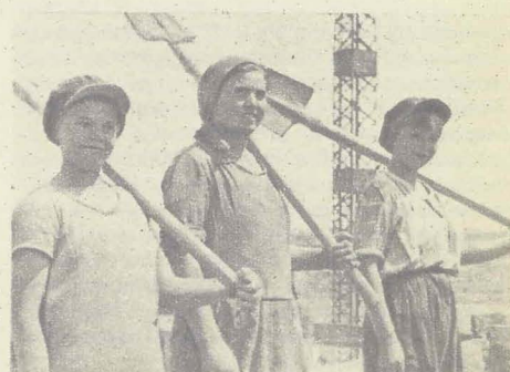
Комсомолки-бетонщицы на строительстве Днепрогэса.
