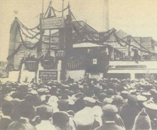
Митинг, посвященный открытию Каширской районной электростанции. 6 июня 1922 г.
